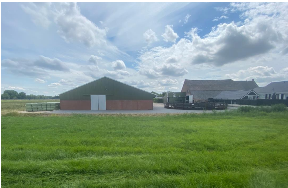
Figuur 1.5 zijkant bebouwing
