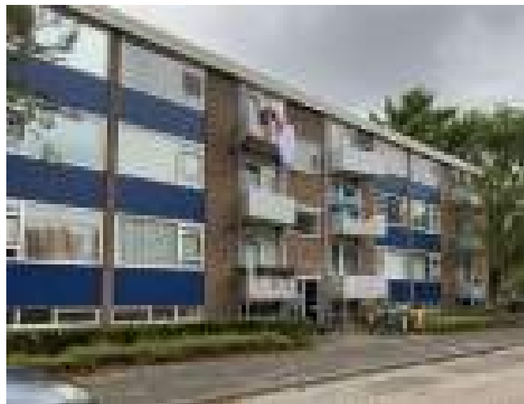
huidig beeld te renoveren flats, verrommeling in kleurgebruik en aan gehangen balkons
