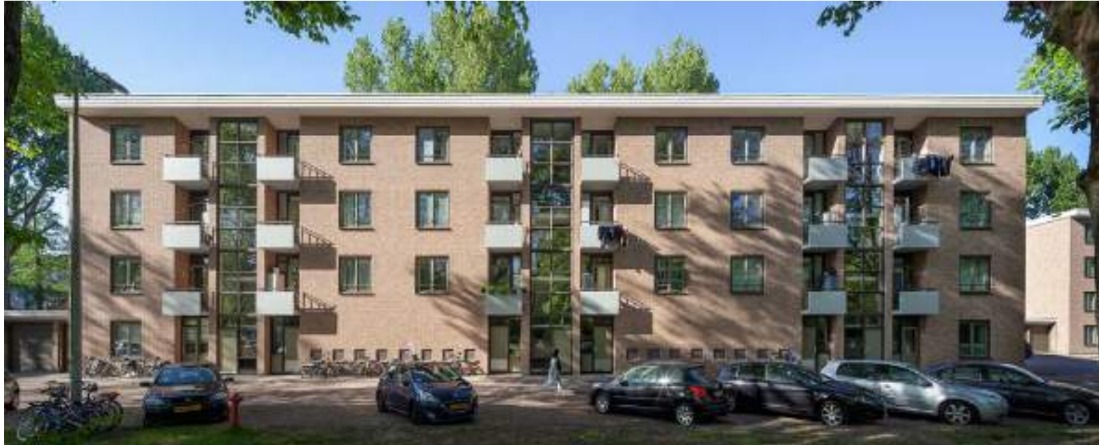
rust en eenvoud terugbrengen in gevel
