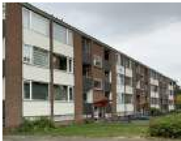
huidig beeld te slopen flats, verticale metselwerkstructuur nog duidelijk zichtbaar met terughoudend kleurgebruik
